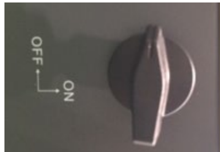
Figura 98 - Seccionador fotovoltaico
