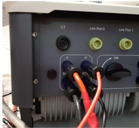
Figura 148 - Conexión de potencia CC lado inversor con doble entrada de baterías poblada
