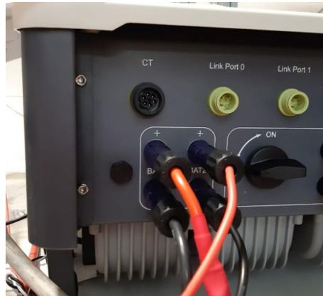
Figura 56 - Conexión de potencia CC lado inversor con dos entradas de batería pobladas
