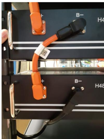
Figura 45 - Conexión de potencia (negativo) entre BMS y último módulo de batería
