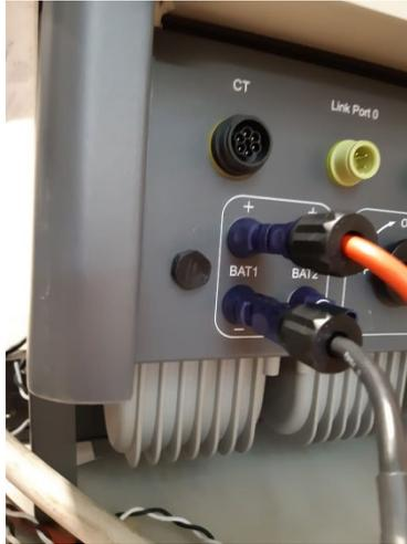
**Figura 48 - Conexión de potencia CC lado inversor con una sola entrada de batería poblada**
