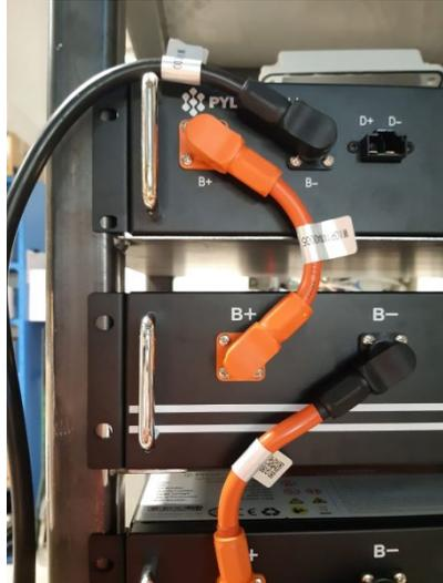
Figura 44 - Conexión de potencia (positivo) entre BMS y primer módulo de batería
