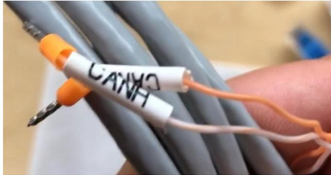
Figura 81 - Cable de comunicación Inversor/HV BOX
