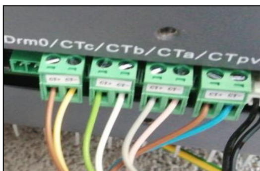
Figura 78- conexiones de los cables CT para las sondas de corriente
