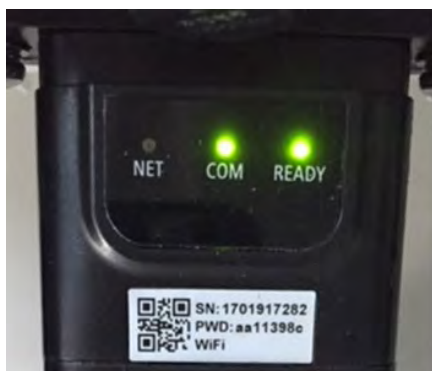
Figura 97 - Estado de comunicación irregular entre adaptador y servidor remoto
